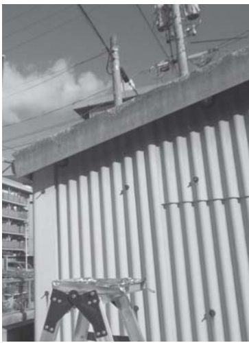
アスベスト含有建材。身近なものにアスベストが含まれている危険性がある。
