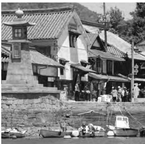
江戸時代の港湾施設が今も残る鞆の浦。雁木、波止、常夜燈は御影石を利用して作られている。
