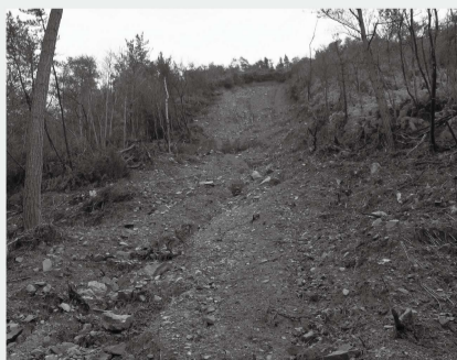
オオバヤシャブシの樹皮(上)、豪雨による崩壊は樹木の根より下で発生している(下)
