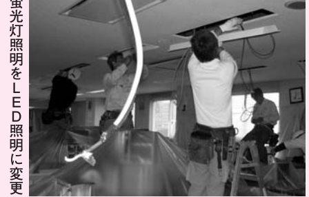
蛍光灯照明をLED照明に変更
