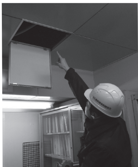
点検口から目視検査を行う職員
