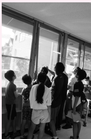
内窓を設置している様子
