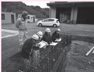
リサイクル施設の鉄筋を検査している様子(上)、地元住民に環境への影響を説明している様子(下)
