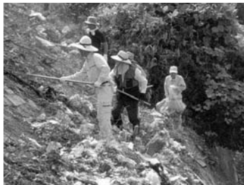
道路脇の法面を複数の団体と清掃した（呉市安浦地区）
