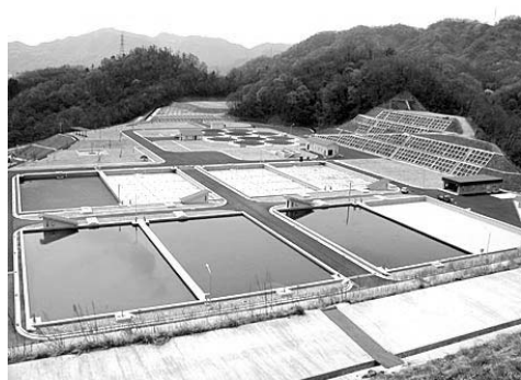
緩速ろ過池 (写真提供 三原市水道局)
