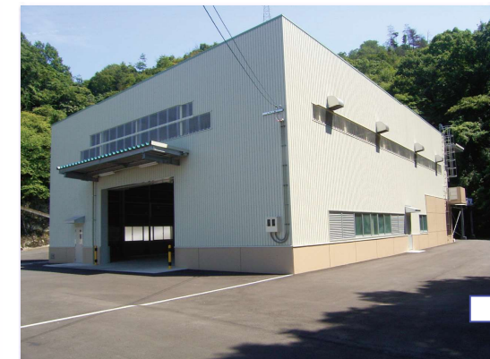
資源ごみストックヤード （焼却施設解体跡地）
