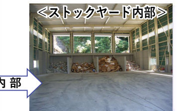
ごみ中継施設及びストックヤード
